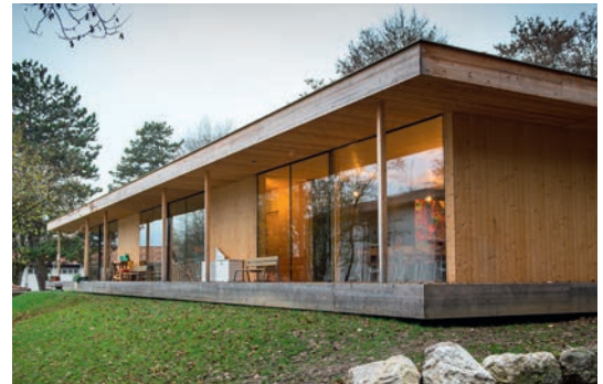
Schnell und sicher: Kindergarten in 2 Tagen fundiert.
