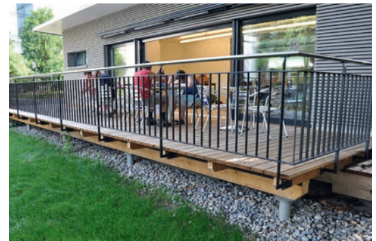
Holzbau – von Terrassen bis zu kompletten Wohnhäusern
